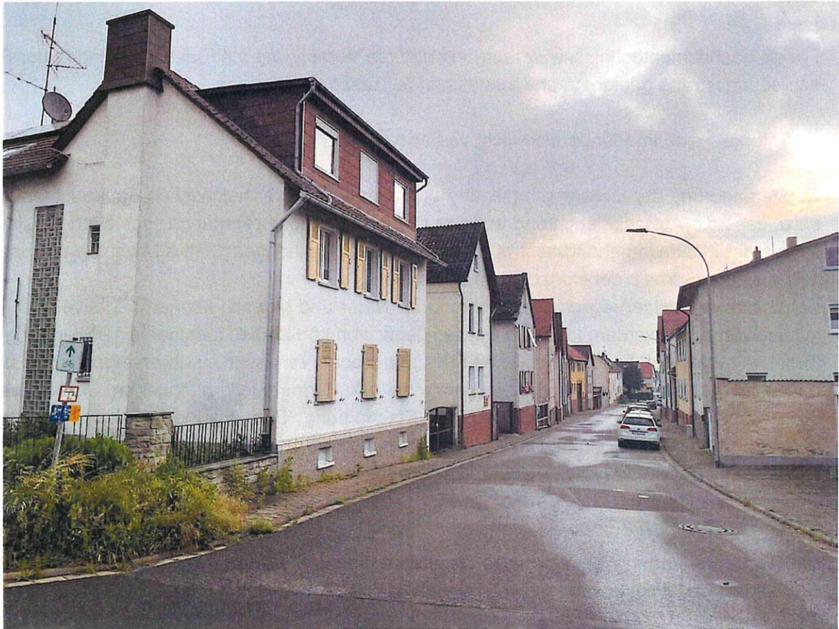
Foto: Blick in Richtung Nordosten auf die Gebäude des Geltungsbereiches (Aufnahme: Ingenieurbüro Zillinger, Juni 2021)
