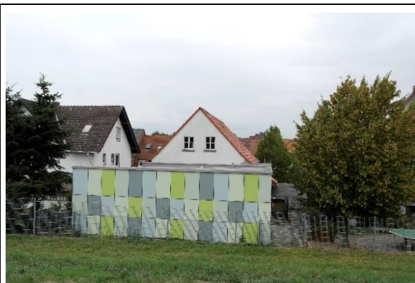
Foto 7: Anbau an Hauptgebäude 2
