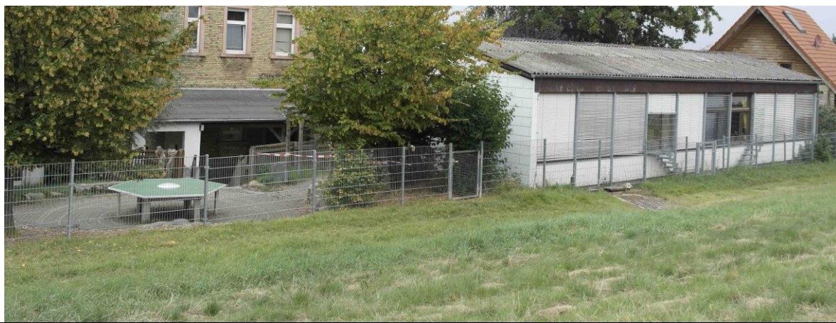
Foto 14: Schulerweiterungsfläche, südlicher Abschnitt Geltungsbereich
