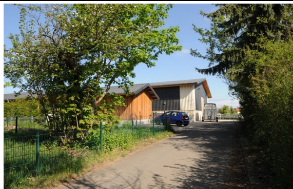
Abb. 9: westlich angrenzende Reithalle
